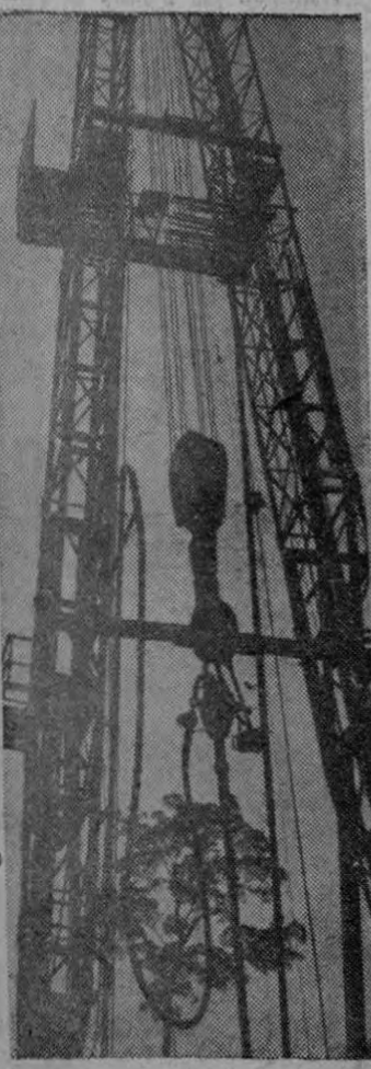
En la foto aparece el barreno de la torre de perforación de uno de los pozos que sondan en la zona atlántica
